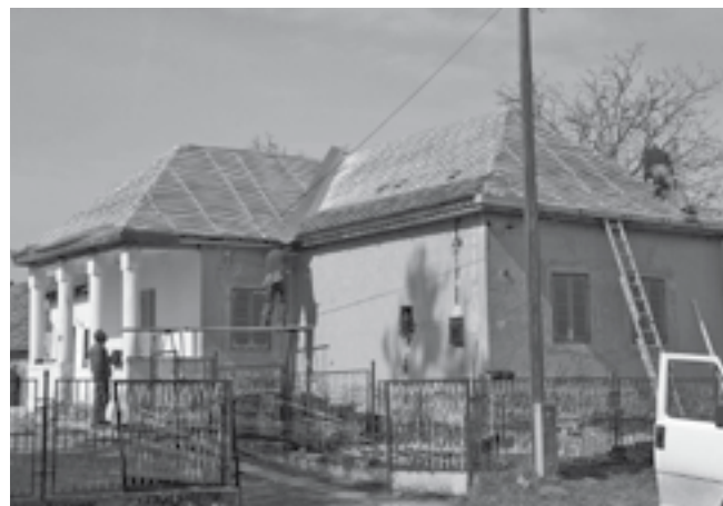
A töredezett 50 éves pala helyett jó minőségű bontott hódfarkú cserép kerül az épületre
